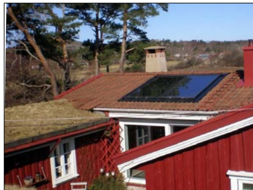
Ett varmvattenpaket i drift
